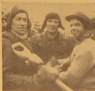
Leidningen från rensningsanläggningen ner till sjön måste grävas för hand då marken inte bär en grävmaskin. De är tre glada gossar Ador, Thomasson, Ivar Holmlund, Allden och Evert Nyberg, Nyåker, som har tagit sig hand om det jobbet.
