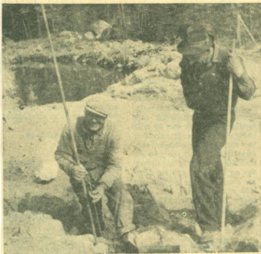
Kalle Hallin, Levar, laddar med dynamit under överinseende av sprängarbasen Stig Krusell.
