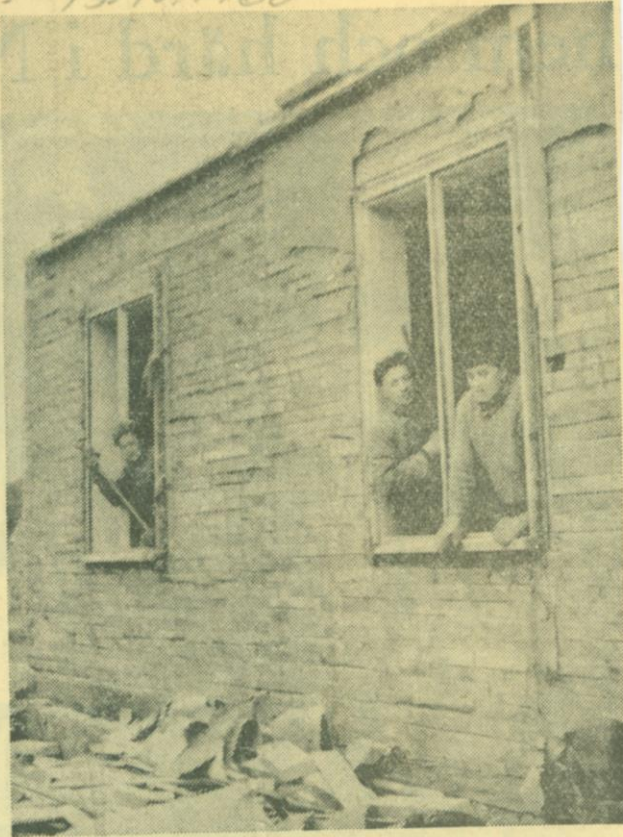
Rivningsmanskabet kikande ut genom fönstergluggarna, fr. v. Gustav Lindberg, Sven Ohman och Osten Söderström.
