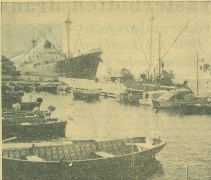
NORDMALINGS NYA KAJANLÄGGNING fylldes helt på fredag. Främst genom tyska fartyget Altair, som har utrymme för nära 1.000 stand. trävaror. I Nordmaling lastade han för, sågverksägare Torsten Nordströms räkning. Den bit som blev kvar av kajanläggningen togs i beslag av en kolbåt. 22/8 1960
