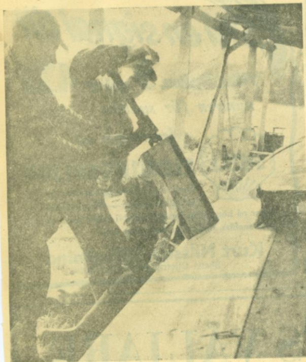
Med den här tvingen, som gjordes för minst hundra år sen vid Olofsfors bruk, får man bukt med de mest motspänstiga bräder. Det är inga lätta grejor. Här är det Agaton Agestedt och Nestor Jonsson som hjälps åt att hålla, medan Sören Agestedt som bara har stöveln i bilden, får ligga under och passa in tvingen i rätt läge.
