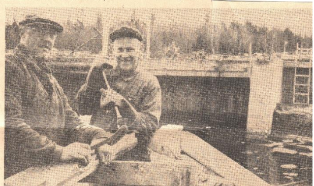
Landfästet vid Lögdeälvens östra strand är färdigställt, endast en del städningsarbeten samt åter- fyllning återstår. Städare och rensar plank gör här Ivar Öberg, Levar och Emil Edstrand, Lögdeå
