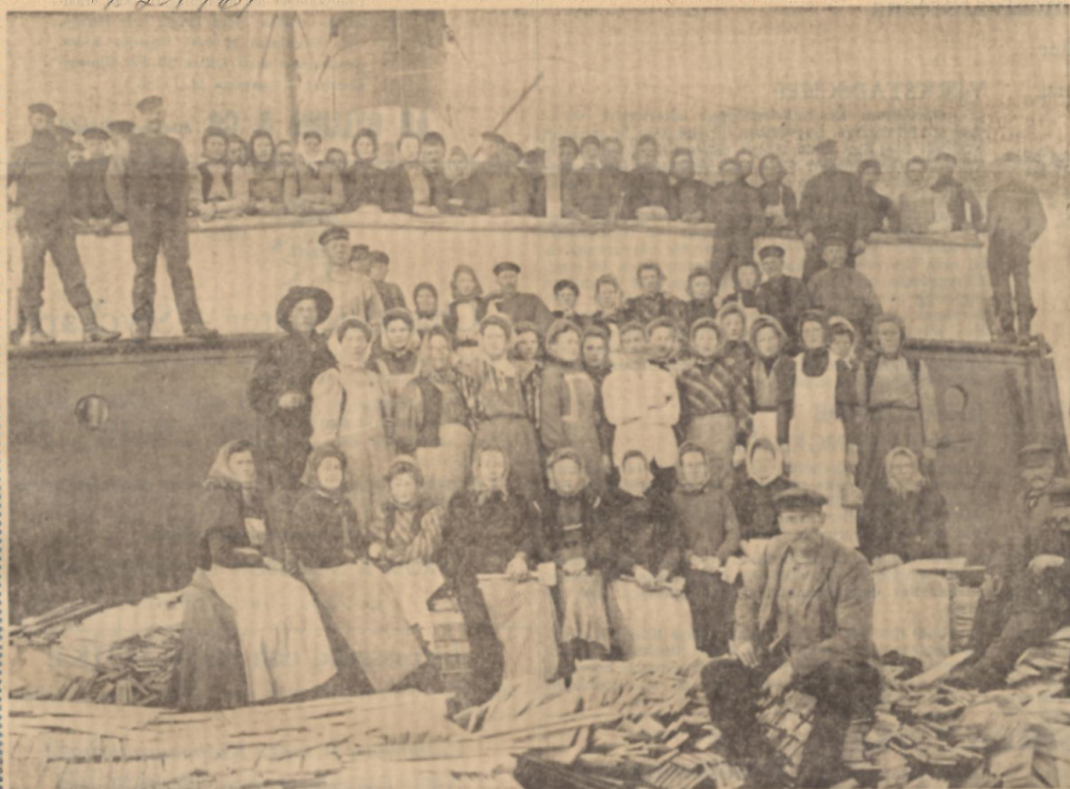
Stuvargänget på s/s Sito av Esbjerg lastande 400 standert stav i Rundviks hamn 1908.
