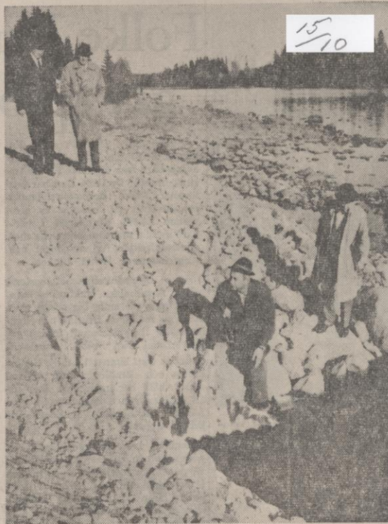
Vägdirektör Hans Rönström synar kulverten som går under Gavelbänken och möjliggör båtförbindelse mellan Gumpen och Nabbsundet. Vid hans sida kontrollanten för vägbygget verkställare Otto Stenmark, Nordmaling medan entreprenören Bertil Moström och ingenjör Tor Bengtson s. a. s. följer synen från ovan.
