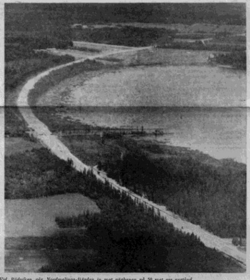
Vid Rödviolen på Nordmalings-fjärden in mot vägbanan på 50 meter ers utstånd
