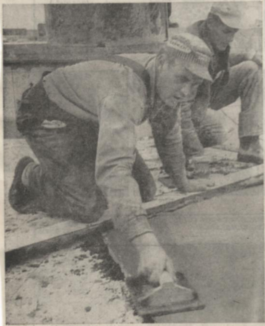
Bröderna Roland och Erik Westerlund från Klemensnäs i arbete med cementslipning på tornets topp.
