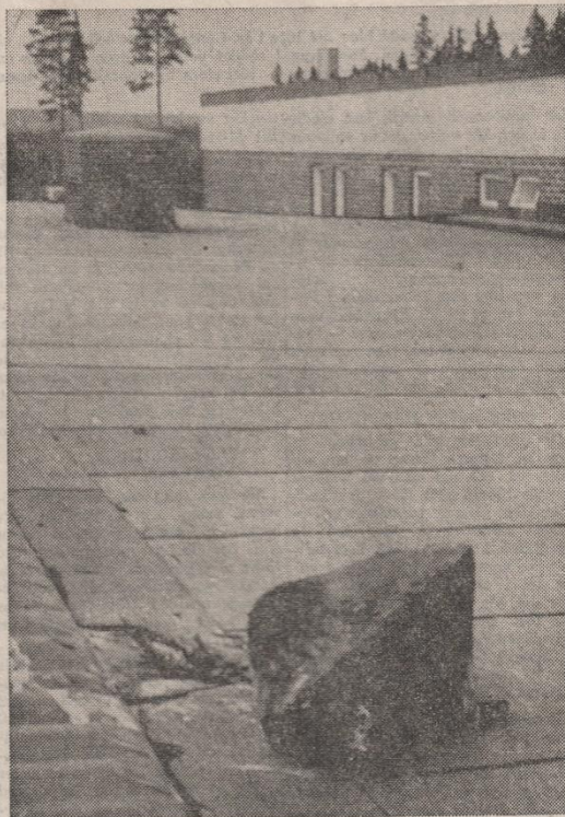
Den här kraftiga stenen hamnade på fabriken tak där den slog sönder en av de bärande takbjälkarna. Hela taket bär spår av den omilda behandlingen.
