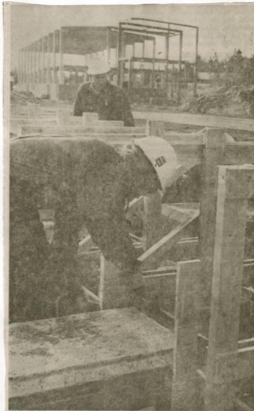
Byggnadsnickarna Gendy Nylander, Umeå och Holger Lundgren, Hemmingsmark arbetar med formsättning av betongplattor för timmersorteringen. 14.10.1971
