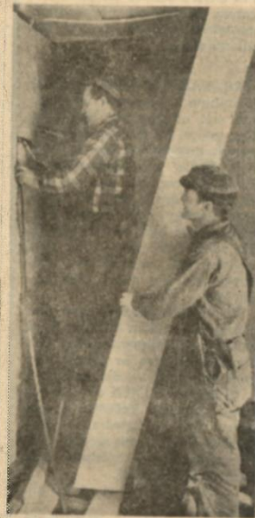
Byggnadsnickarna Sigvard Ahlgren och Roland Molin i färd med att sätta upp Masonite-slitpanel i Nordmalings idrottsförenings klubbstuga.
