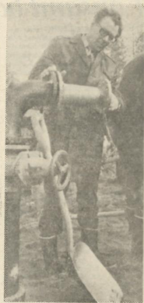
Vattenverksskötare Torsten Braxenholm vid anslutningen till ett av de nya borrhålen.
