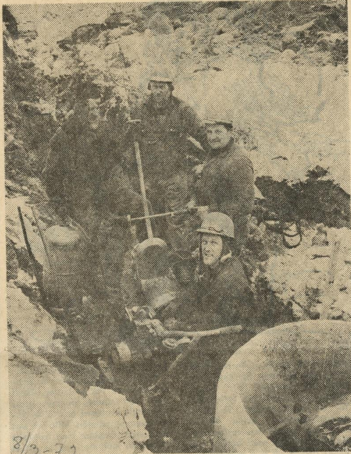
Rörläggargänget vid VA-projektet på Levar-åkern David Dahlberg, Karl Markström, Gustaf Törmä och Bengt Ejelöf.
