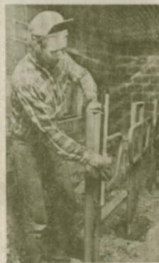
Rolf Hellberg är en mångsysslare, bygger, skötar m.m. Här under monterar av den utbyggda ladugårdens moderna inredning.
