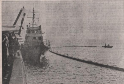
Här håller man just på att ringa in ett fingerat oljelänsa i Nordmalingsjärden med Expandilänsan.
