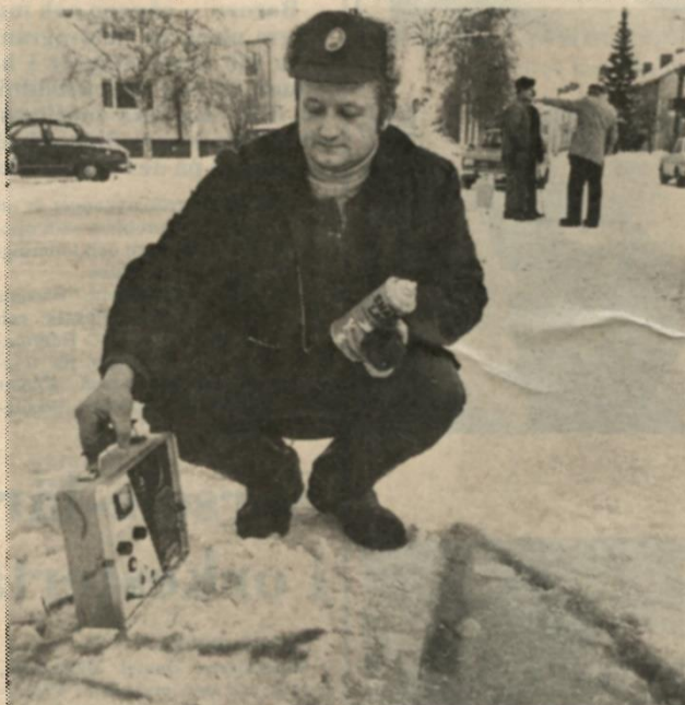
• Det gäller att inte gräva sönder televerkets ledningar när gatukontoret sätter igång. Därför kollar Lage Hortell var han har sina kablar och märker ut det med sprayfärg.
