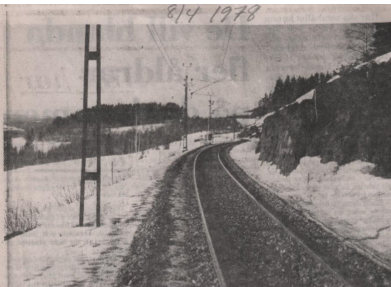
Det är många kurvor på sträckan mellan Tallbergstunneln och Nyåker som nu skall bort.
