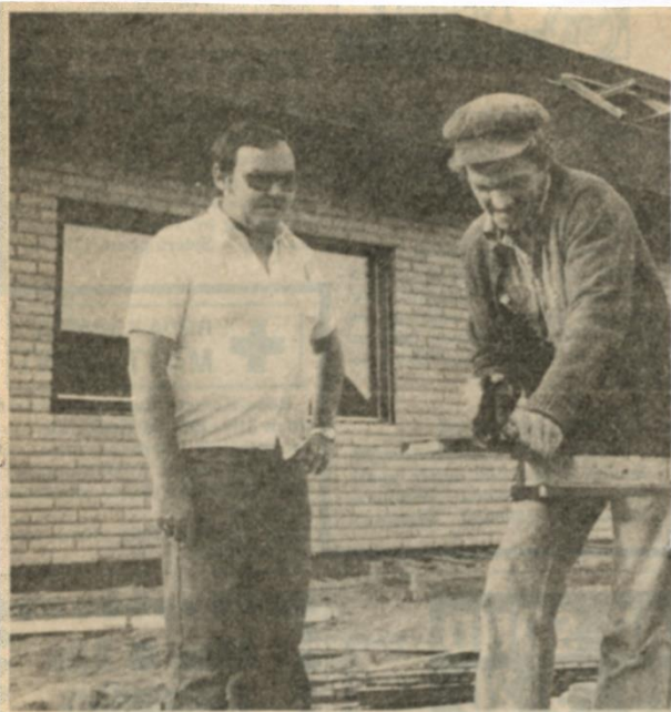
• - Nog är det här huset väl isolerat, säger Hans Berggren, en av de två snickare som byggt upp det första av Uno Hammarbergs lågenergihus. 21/7-78
