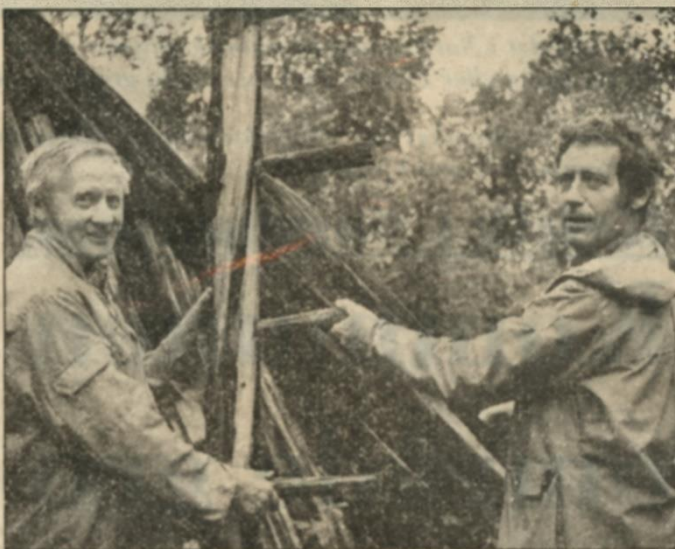
● Riktigt hässjevirke har vi gjort i ordning, konstaterar t v arbetsledaren Alvar Johansson, Nyåker, och t h Stellan Johansson vid Skogsvårdsstyrelsens nordmalingskontor.
