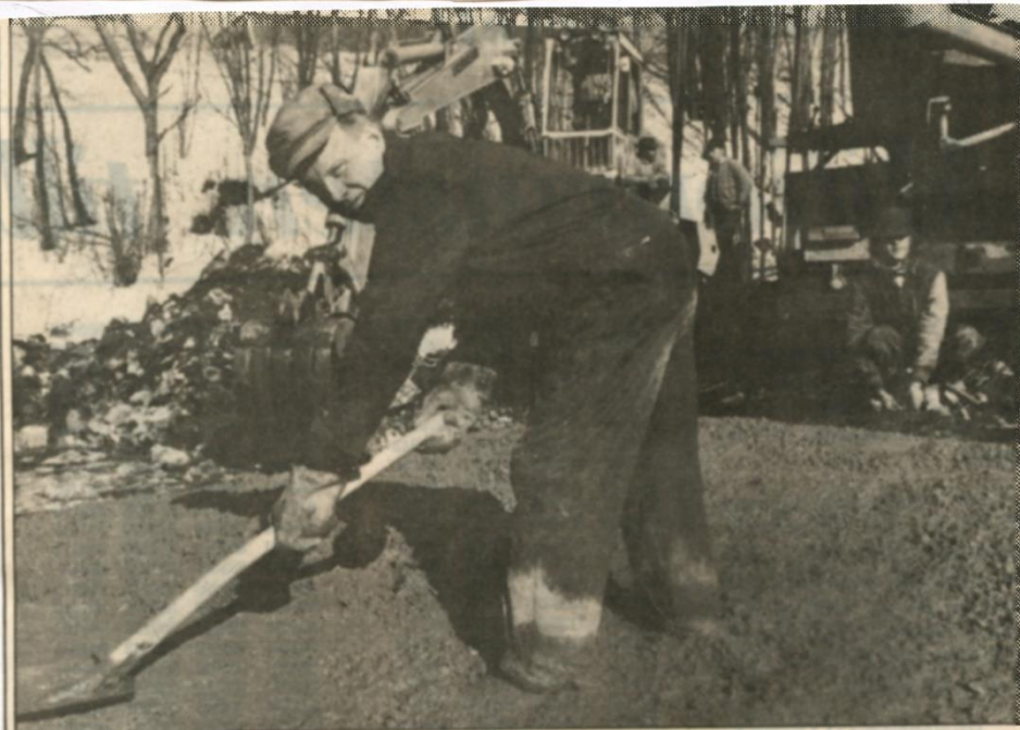
• Sigurd Palmgren, Fredriksson & Marklund AB, slätar till den sista biten av den nya dammen av betong. I bakgrunden ses hantlangaren, Christer Örnstad, som har en ungdomslagsplats.
