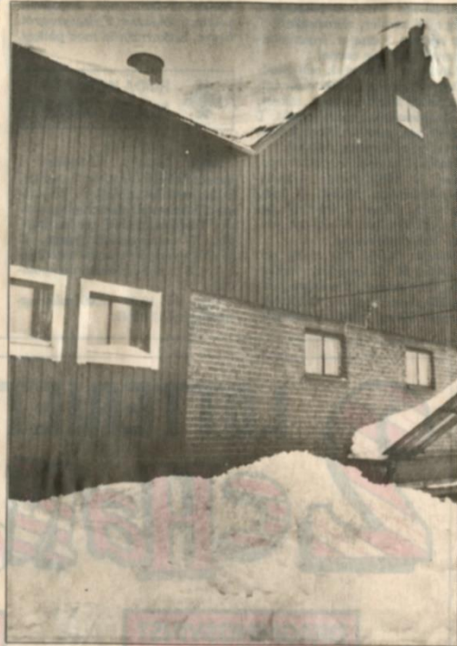
• Verner Jakobsson arbetade på taket med att skotta tung blötsnö när plötsligt allt lossnade. Han störtade 7 meter och föll på rygg mot en betongvägg.
