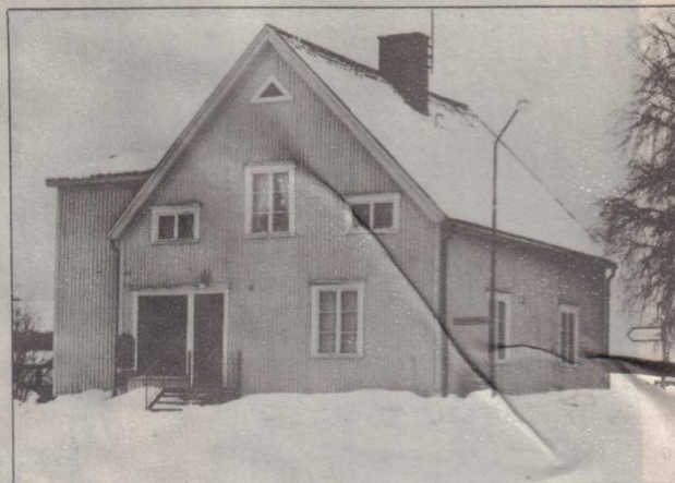
● Huset på bilden rivs och ska lämna plats för ett hyreshus med åtta lägenheter. På tomten stod ännu tidigare det första timmerhus som Lind byggde men som brann en vinternatt. Huset som nu rivs har fyllt många uppgifter som bostad, bank-lokal, sportaffär, läkemedelsförråd, beklädnadsaffär m m.
