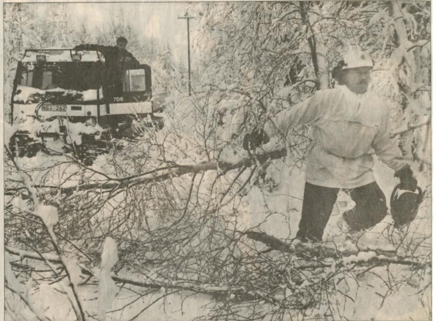
• Ett 25-tal man från Vattenfall röjde milslånga ledningsgator i Nordmaling under torsdagen. För att klara Järnashalvön så snabbt som möjligt inleddes räddningskårens personal och bandvagn för jobbet. Sune O Sjöström höll i motorsågen medan Olov Levander körde fordonet.
