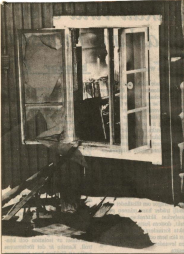
• Vid branden i Olofsfors på lördagseftermiddagen totalförstördes en lägenhet om två rum och kök samt hall.
