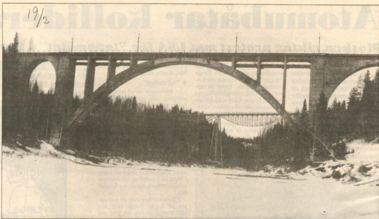
• Den rivningshotade betongbron, invigd 1919, och i bakgrunden järnbron från 1800-talet.
