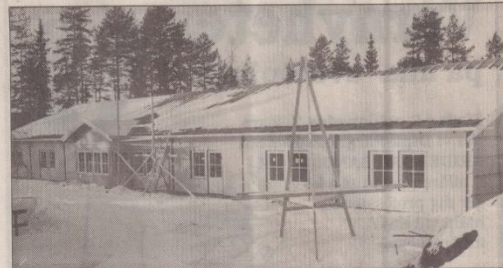
• Intresset för att bo i de två miniålderdomshemmen om 16 platser som nu byggs i Norrfors och Gräsmyr är mycket dåligt. Ännu har ingen hyresgäst kontrakterats.
