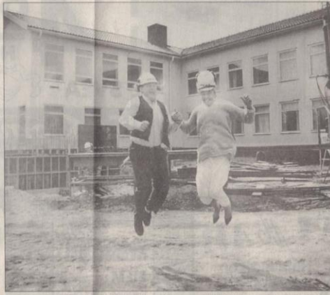
• Rektor Cathrina Strandberg och studierektor Kjell Nilsson på Centralskolan i Nordmaling är hoppfulla. Äntligen har den efterlängade ombyggnationen av den gamla realskolan tagit fart. Om ett år ska ombyggnationen vara klar, men redan i höst händer det nya saker på schemat.
