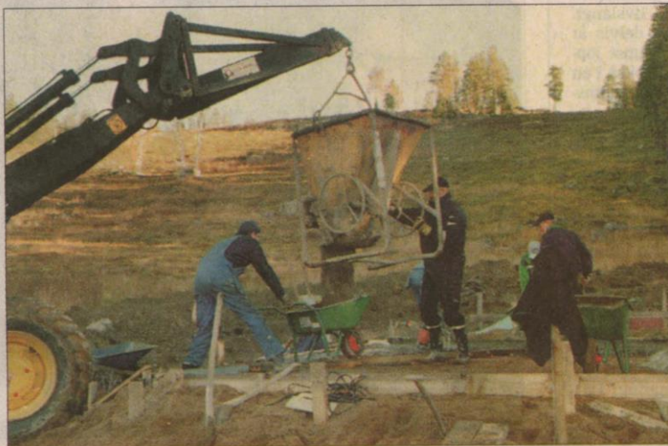
Idoga friluftsförädrarna gjuter grunden till nya pistmaskinsgaraget.
