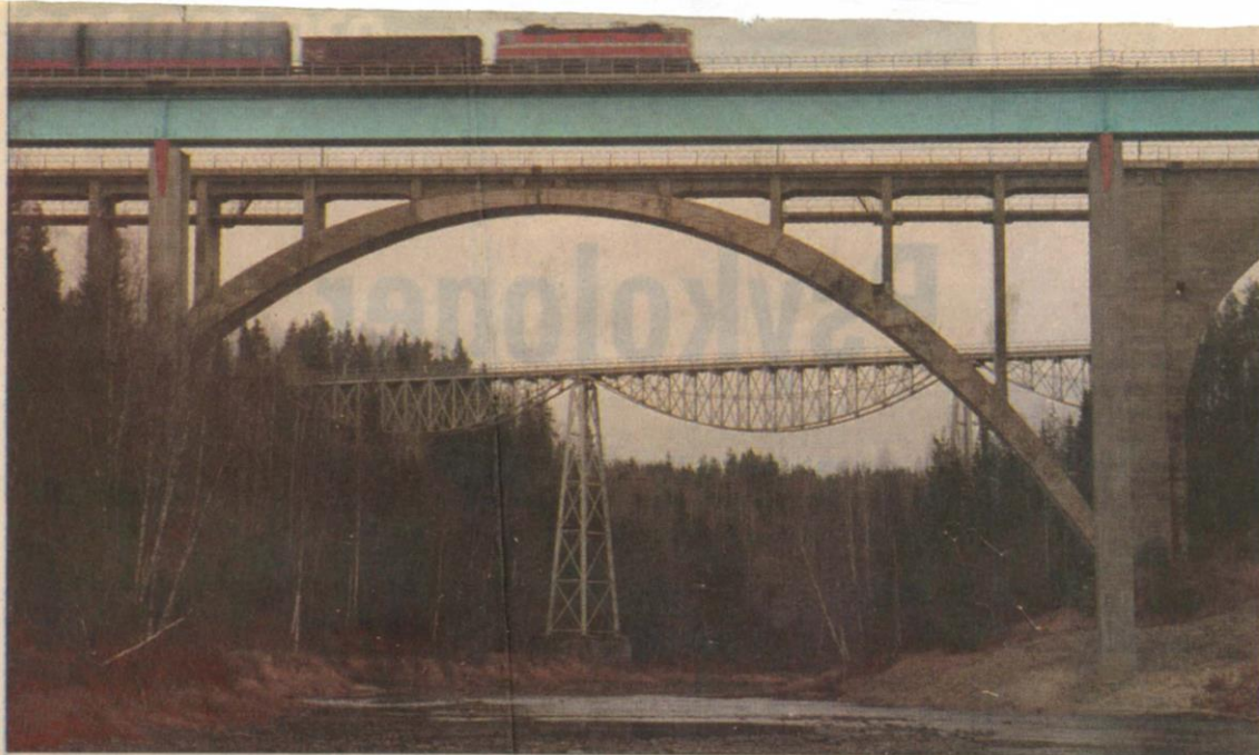
Närmast går ett tåg över den nya slälbron klar 1994. I mitten syns Tallbergsbron i betong och längst bort stålfackverksbron från 1891.
