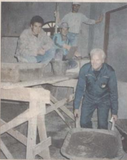
Gregor Allerth har några veckor kvar innan även han åker hem till Sverige och baptistförsamlingen i Nordmaling. Bilden togs för några veckor sedan när putsarbetet i kyrkans hade påbörjats. I bakgrunden tre av de fyra murarbröder som utför arbetet.
