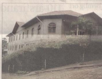
1995 hade taket kommit på plats. Väggarna byggdes upp av arbetskonstnär Gunnar Nordin som under tre månader vistades i Blumenau för att hjälpa till med byggnadsarbetet. I dag, fyra år senare, håller den sista delen på att färdigställas. Det som återstår är en del invändiga arbeten. Allt väntas bli klart till i november när församlingsskolan ska invigas.
