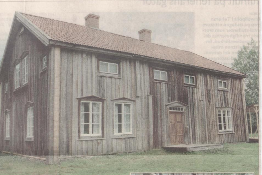
Åbergsgården i Lögdeå är en dubbelkorsbyggnad från sent 1700-tal eller tidigt 1800-tal. Nu har den blivit museum.
