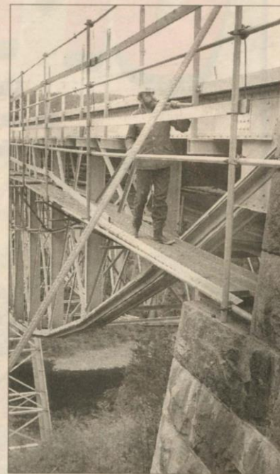
Den nitade järnbron från slutet av 1800-talet genomgick en omfattande reparation sommaren 1984. Ove Nilsson var en i arbetslaget som bytte balkar och breddade körbanan.
