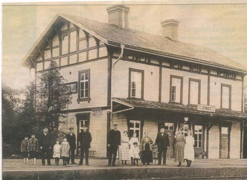
Stationshuset i Hörnsjö i början av 1900-talet.
