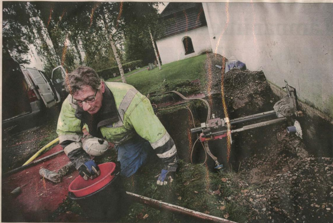
Christer Nordlund, robotförare, borrar i Nordmalings kyrka för luftvärmepump.
