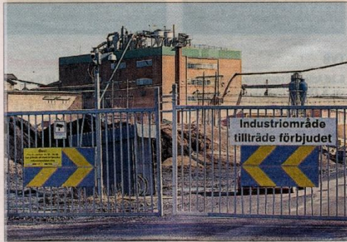
Japaner var intresserade att starta tillverkning av mikroalger i den gamla Masonite-fabriken i Rundvik. FOTO: PER LANDFORS
