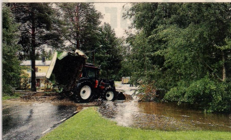
7 juli 2009 spolades vägtrumma och bro bort av vatten massorna efter ett skyfall. Bara de gamla stenfundamenten från 1920 stod pall.
