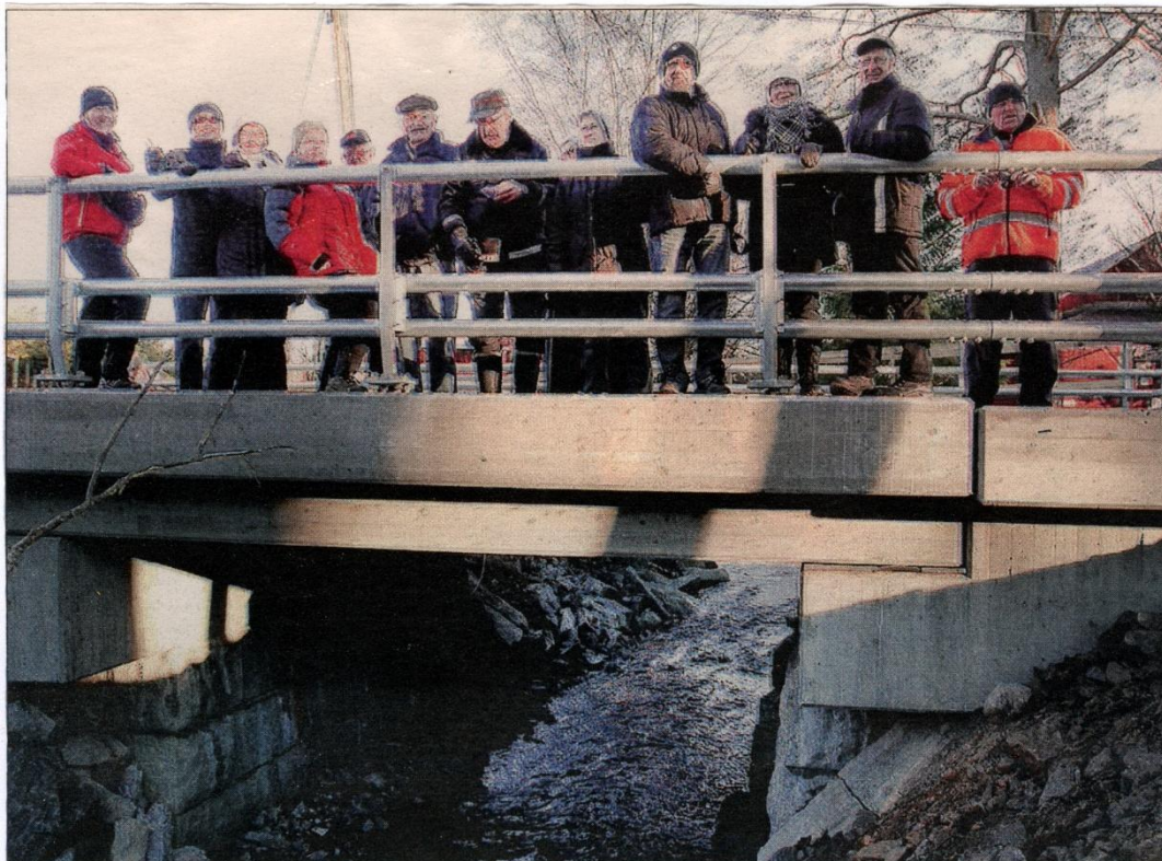
Den nya bron är byggd på de gamla stenfundamenten till bybornas glädje.
