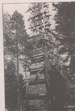
Byggnation av klockstapeln i Hörsnjö 1952.
