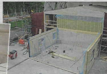
Prefabricerade element i Kv. Kullen.
