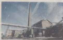
Masonite har fått en stororder.
