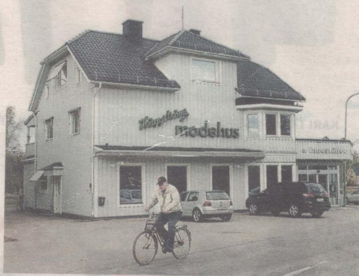
Domen i förvaltningsrätten visar att det var fel av politikerna i Nordmalings kommunfullmäktige att besluta om att ge borgen till ett företag som planerade att bygga ut sin verksamhet.
