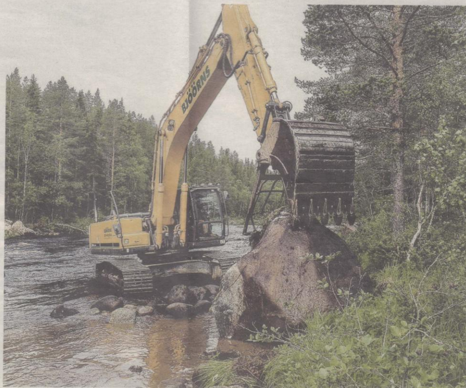
I restaureringsarbetet återförs bland annat block och stenar, öppnas avstängda sidofårar samt breddas vattendraget till ursprunglig bredd igen. Restaureringen är en del av miljömålet Levande sjöar och vattendrag.
