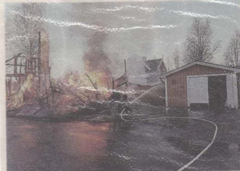
Det var strax innan fem på måndagsmorgonen som garagebyggnaden började brinna.
