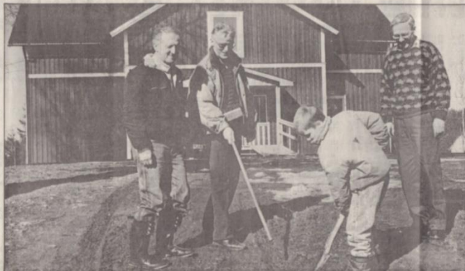
• Det är många som hjälpt till med att få bygdegården klar till invigningen. I stort och smått. Alexander Nilsefur, sonson till Nils Johansson t.h., dränerar vattenpussar under överinseende av bröderna Nils-Erik och Lennart Jonsson.
