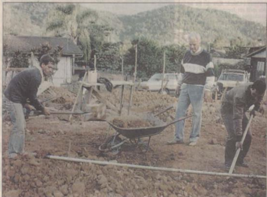
• Gregor Allerth, mitten, tillsammans med två av medhjälpare i arbetet med grundläggningen av daghemmet. I anslutning till daghemmet kommer även en kyrka att uppföras.
