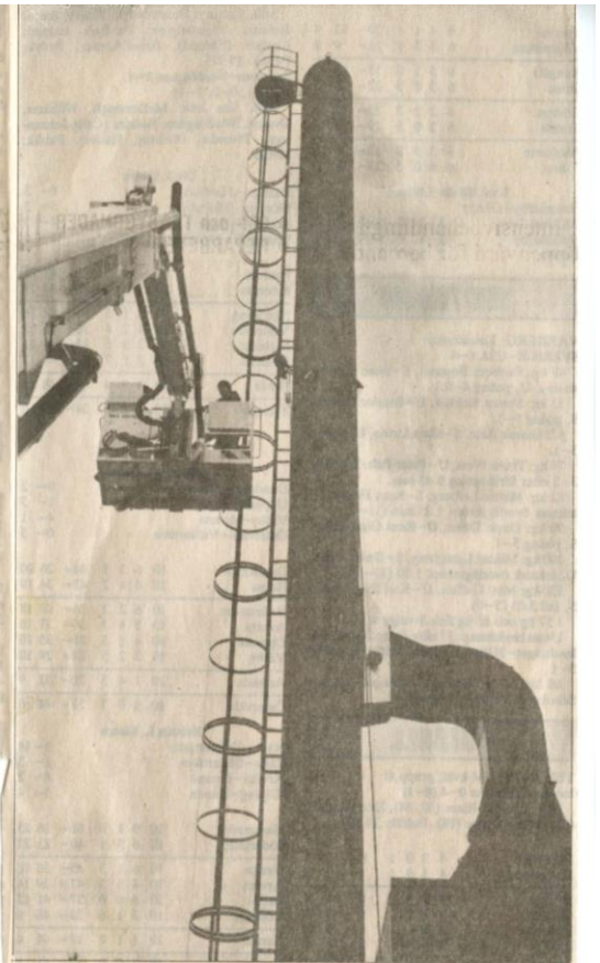
• När nordmalingsborna ser röken från värmeverket kan de lugna sig med att det i huvudsak är vattenånga de ser. Halten av rökstoff ligger dock vid gränsen för det godkända.
